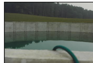
Dichtheitsprüfung einer Neuanlage
