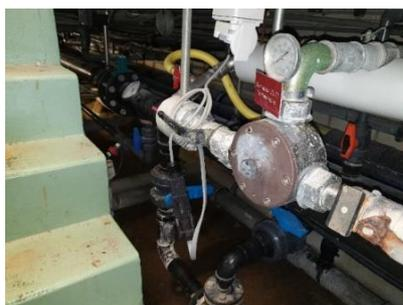
Abbildung 43: Mischventil Duschwasser
