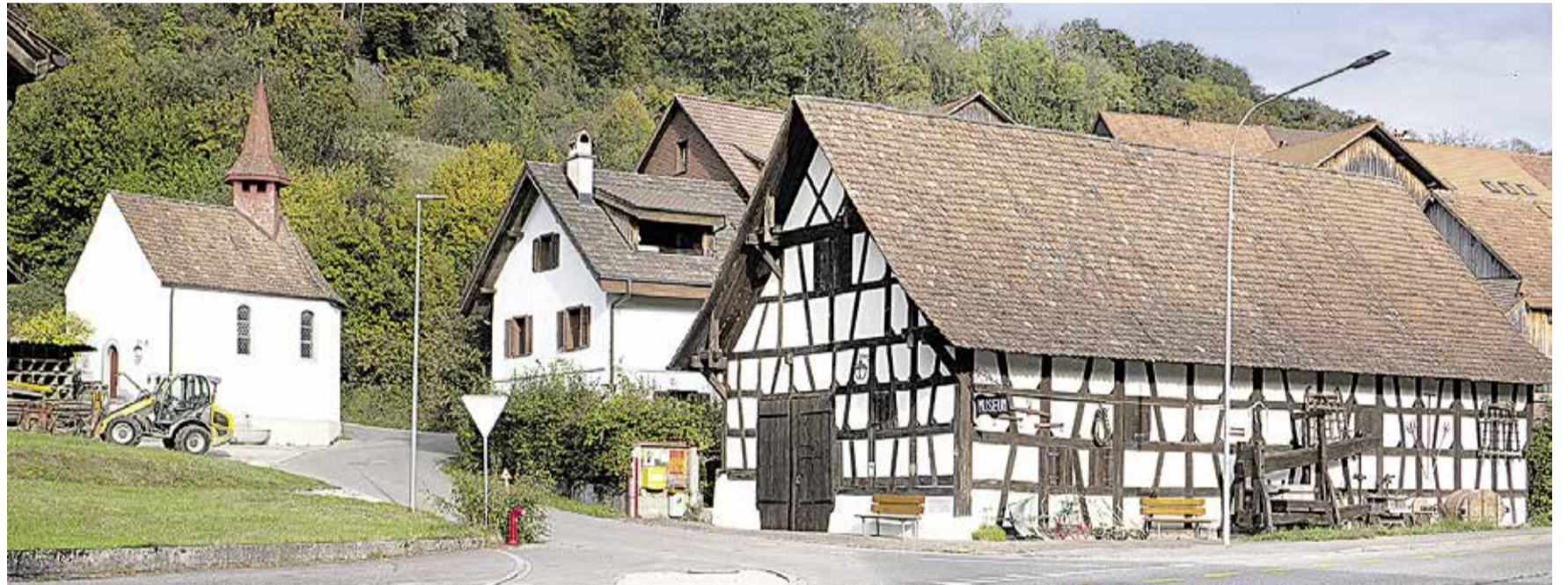
Das Mellstorfer Dorfzentrum wird von Kapelle und Trotte geprägt.
