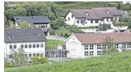
Das von der Privatschule genutzte Schulhaus und die Turnhalle.
