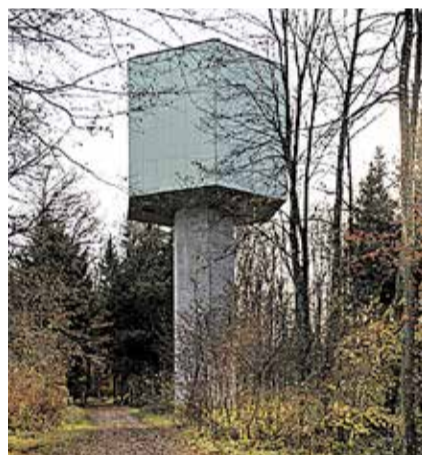
Der Baldinger Wasserturm.
